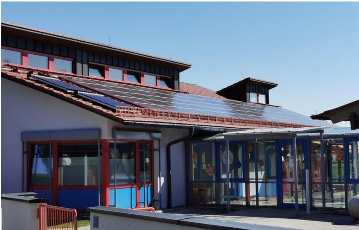
Abbildung 9: Solarthermie-Kollektoren und PV-Generator auf dem Süddach der Kinderkrippe
